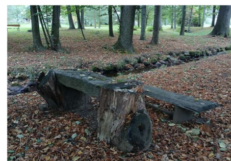
Stávající posezení – problém hnití špalků pod kamennými deskami stolů, prvky jsou nebezpečné,
