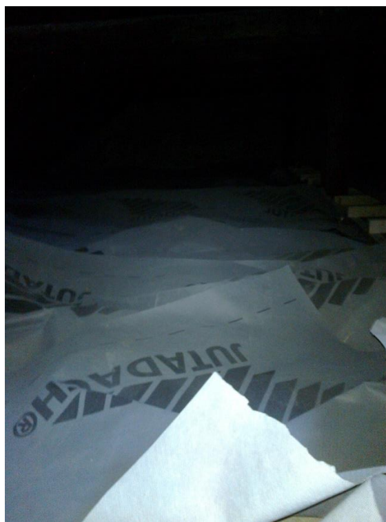
Poškozená ochranná vrstva hydroizolace
