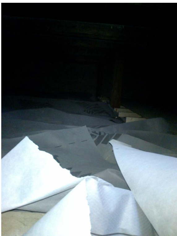
Poškozená ochranná vrstva hydroizolace
