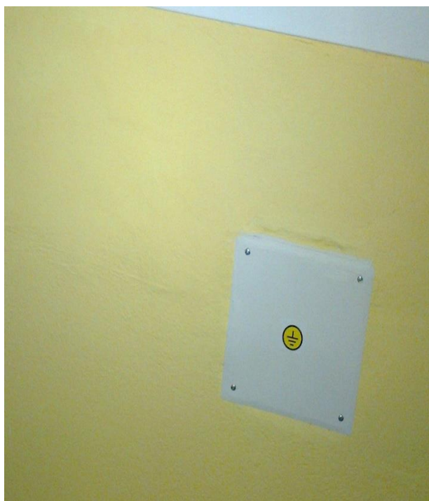
Nevyhlazená omítka po elektroinstalaci
