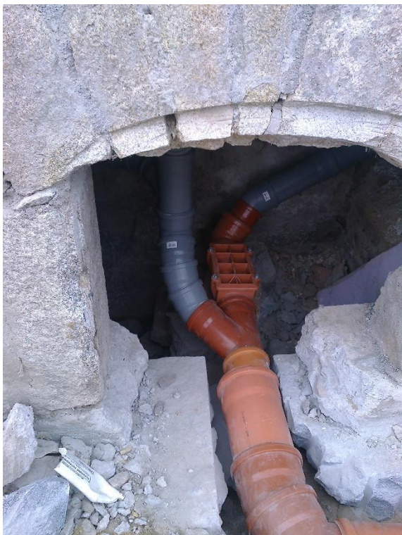
Chybějící dvířka revizní šachty
